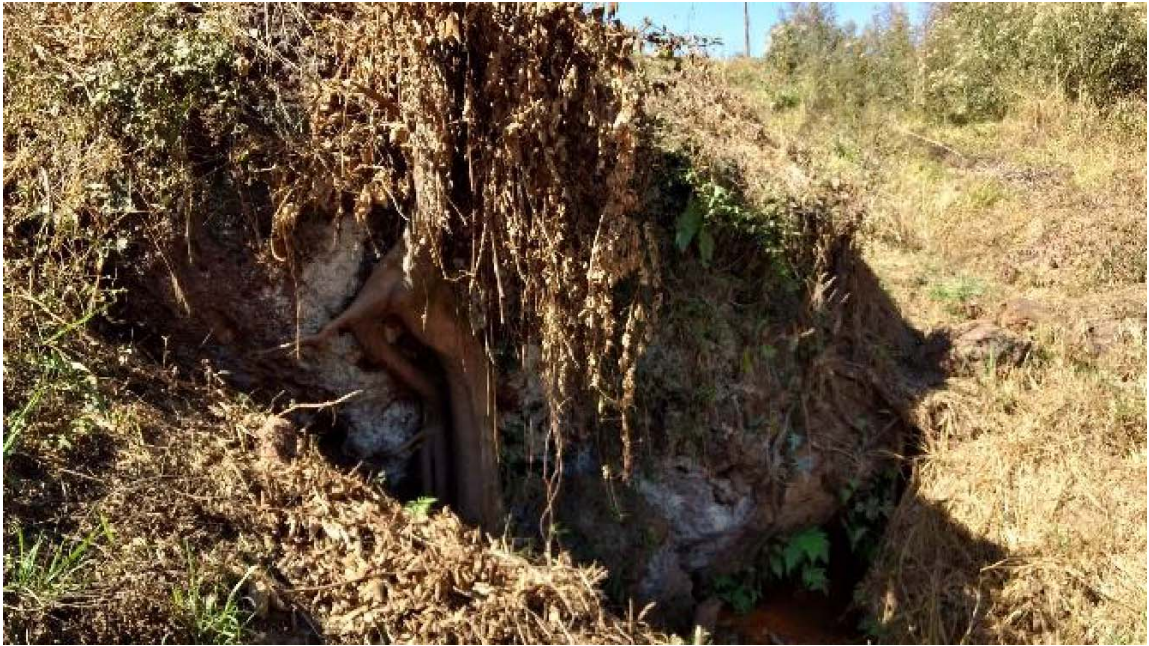
Figura 49: Vista da face exposta do grande bloco de canga existente à jusante do dique inicial da B I
