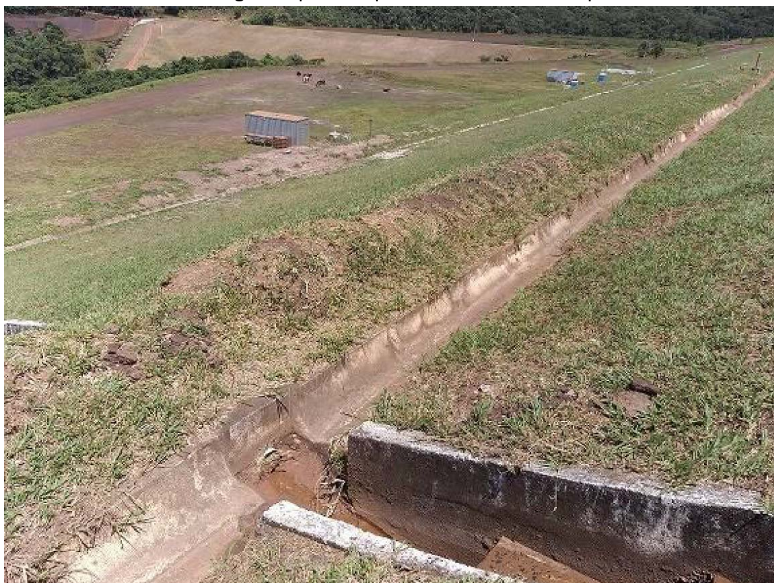
Figura 110: Canaleta de drenagem superficial parcialmente obstruída por lama
