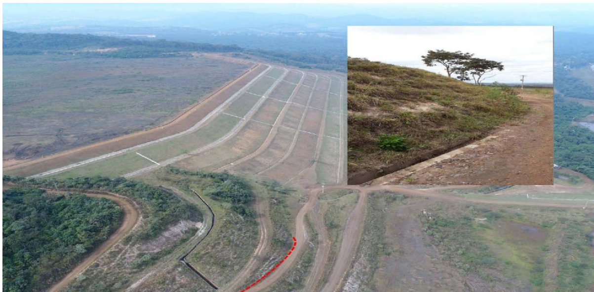
Figura 111: Canaleta de drenagem superficial assoreada
