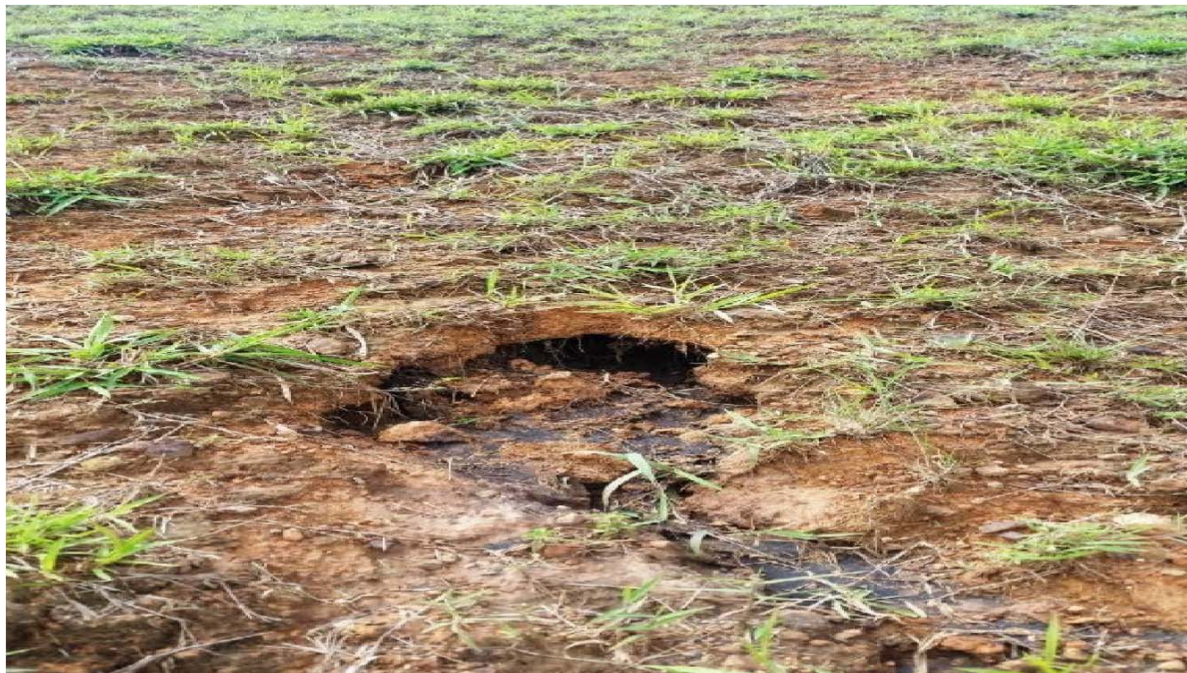
Figura 120: Erosão (ravina) no talude
