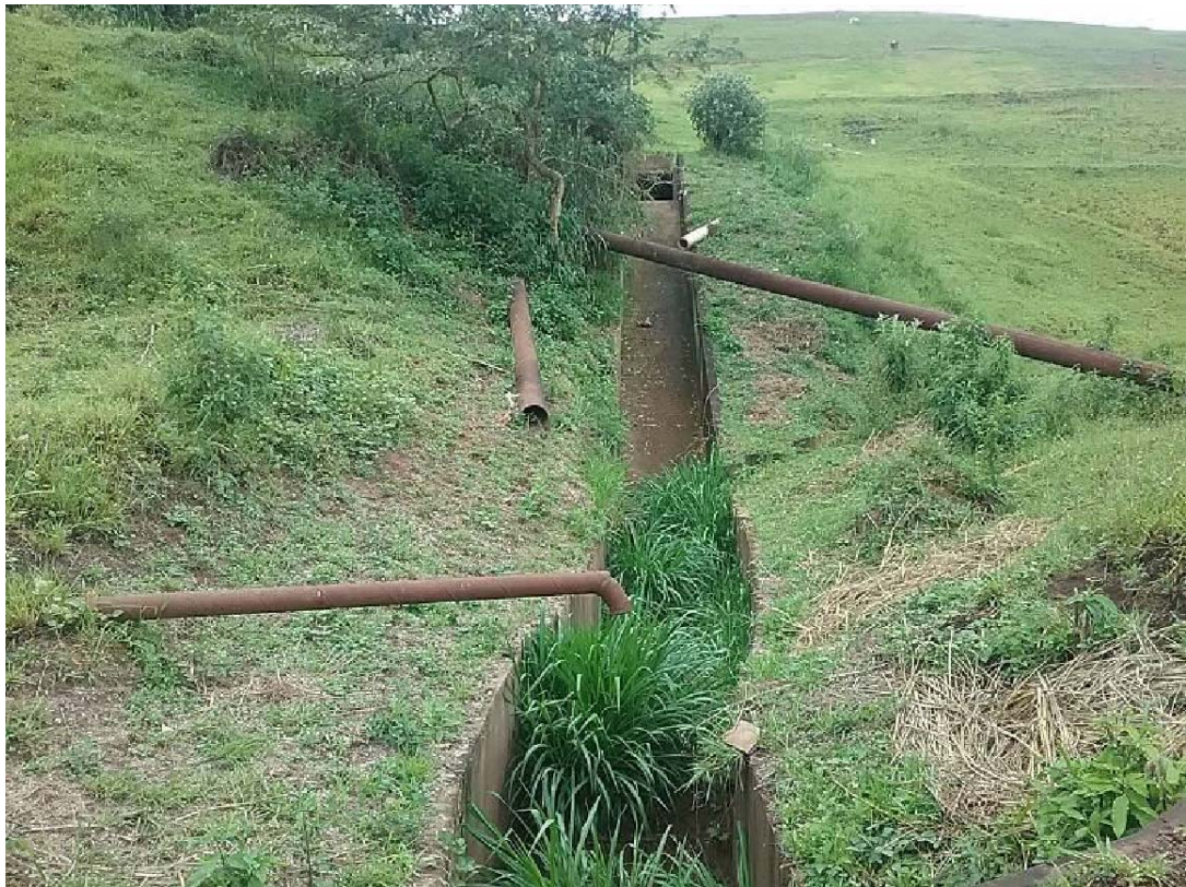
Figura 94: Obstrução de canaleta por vegetação
