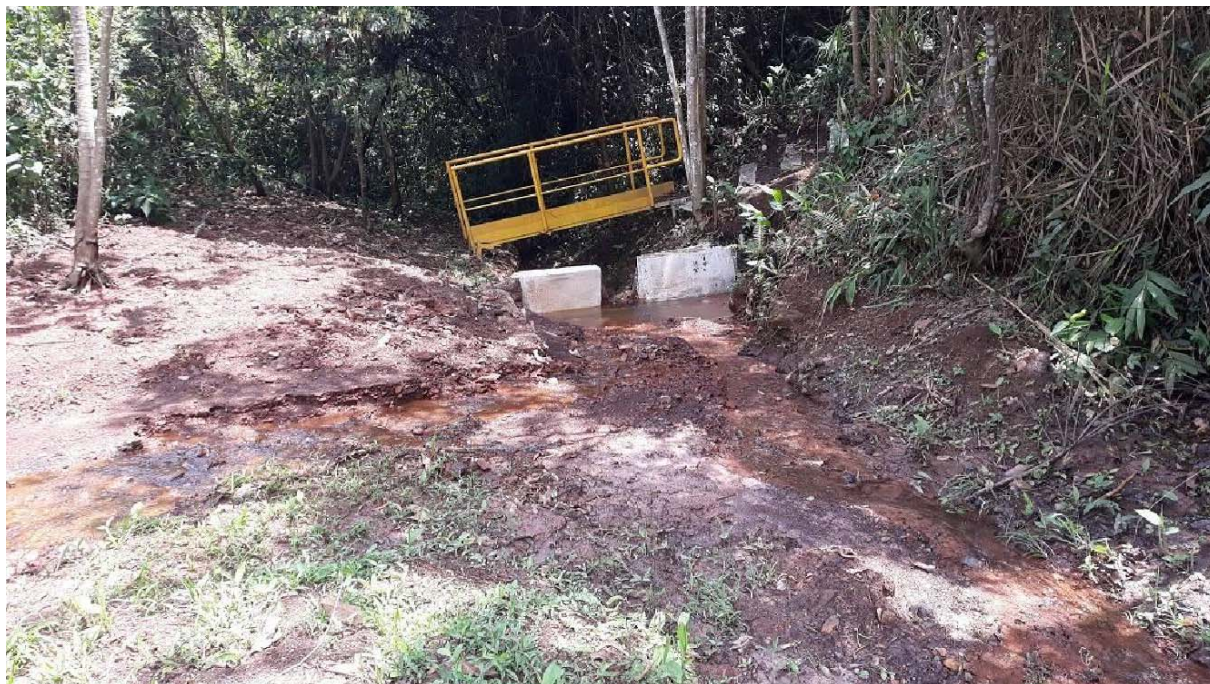
Figura 114: Carreamento de material (colóide) na saída do dreno
