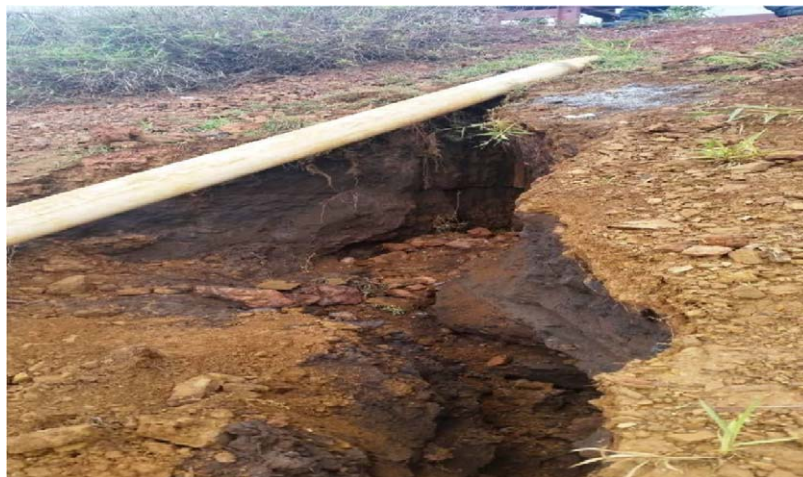
Figura 118: Erosão causada por vazamento de água da tubulação de drenagem que foi danificada por gado
