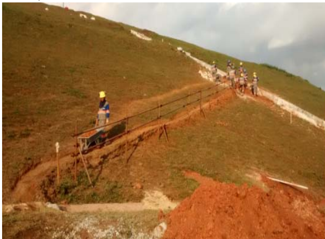
Figura 38: Serviço de retirada de solo escavado do local onde ocorreu a fratura hidráulica
