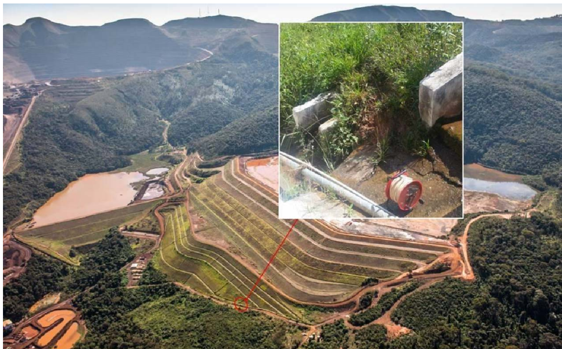
Figura 97: Surgência no talude do barramento
