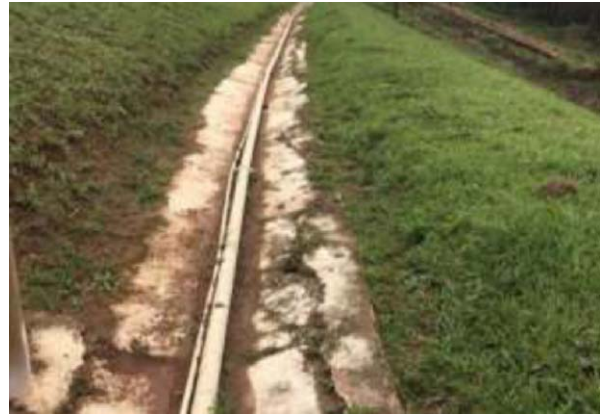
Figura 56: Canaleta de drenagem superficial na B I com danos no concreto
