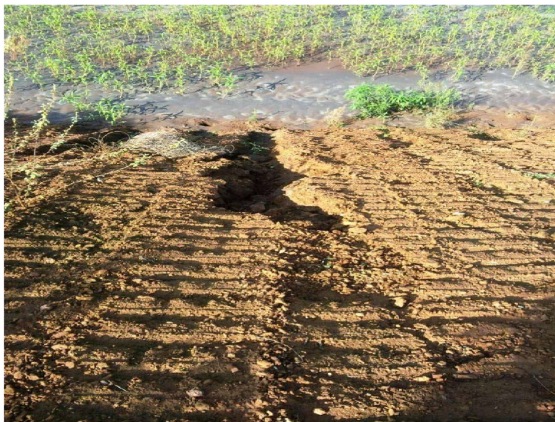
Figura 117: Erosão (ravina) no talude do barramento
