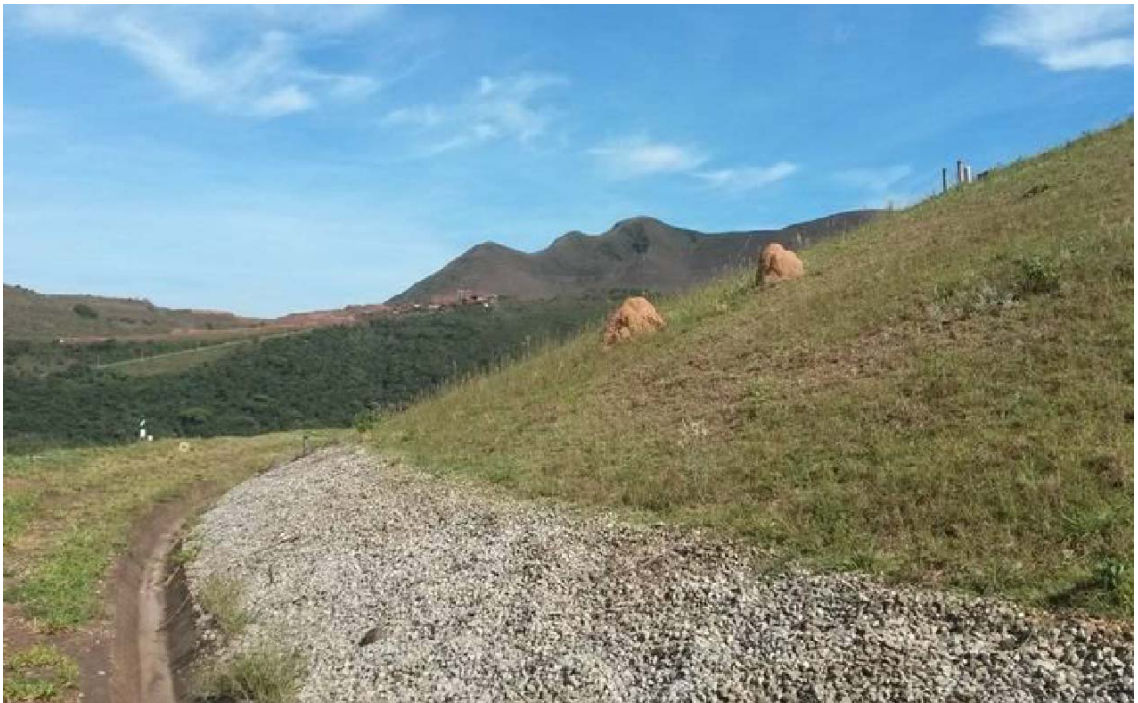
Figura 129: Formação de cupinzeiros no barramento
