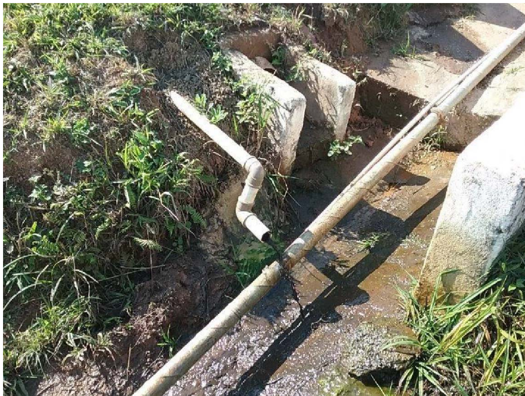
Figura 115: Saída de sedimento pelo DHP
