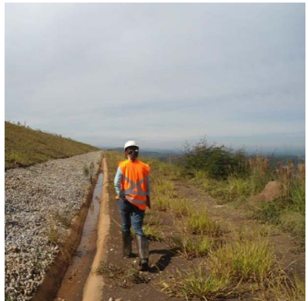
Figura 51: Empoçamento em canaleta de drenagem superficial da B I
