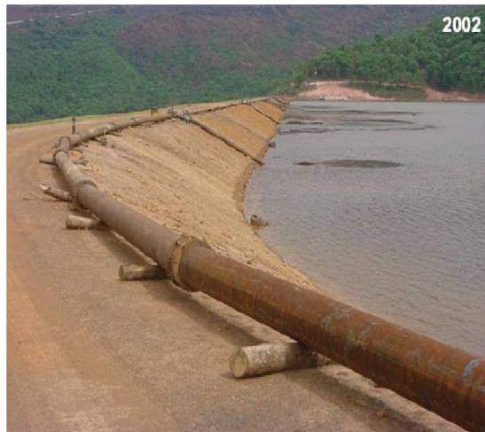
Figura 82: Barragem B I com largura de praia igual a zero em 2002
