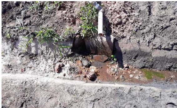
Figura 57: Dano estrutural em canaleta superficial da B I durante instalação de DHP
