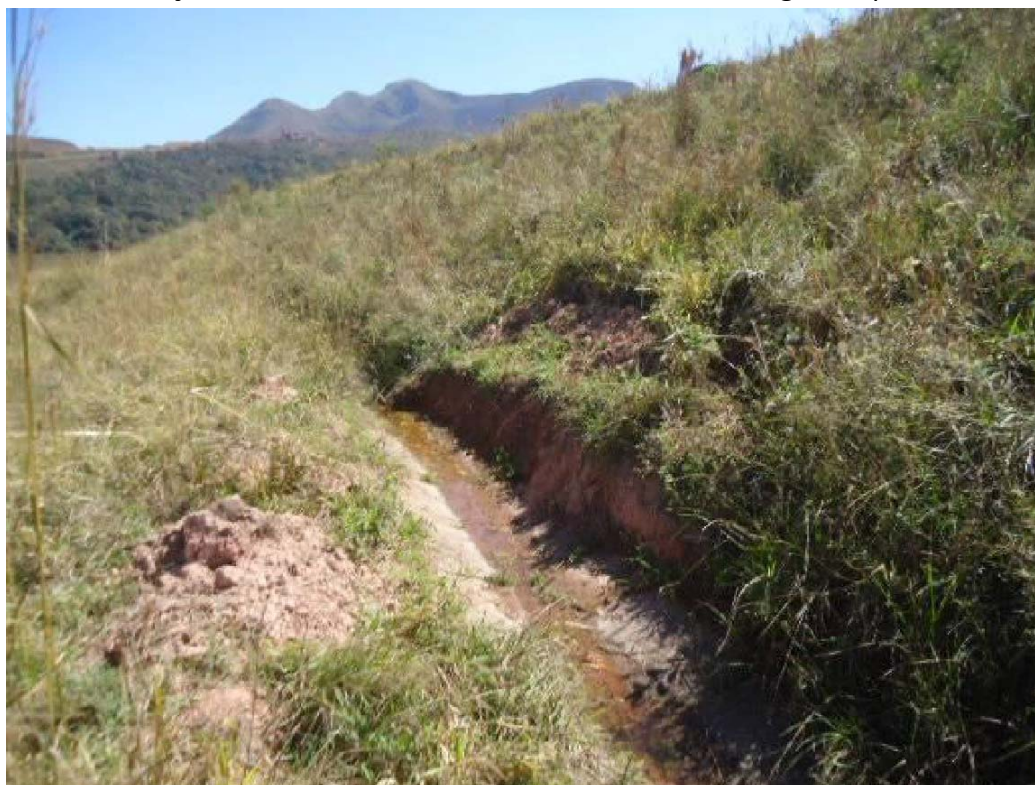
Figura 116: Deformação no talude acima de uma canaleta de drenagem superficial
