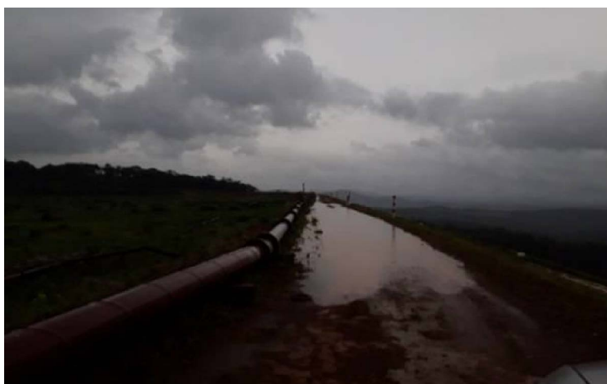
Figura 106: Drenagem superficial da barragem obstruída com acúmulo de água na crista do barramento
