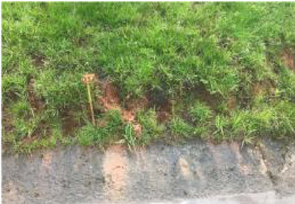
Figura 96: Surgência no talude principal com carreamento de material
