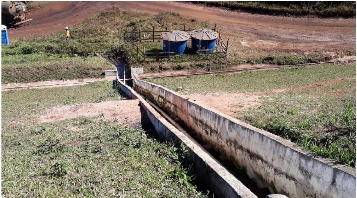
Figura 35: Canaleta em degrau onde ocorreu a surgência de água quando da perfuração de 15º DHP
