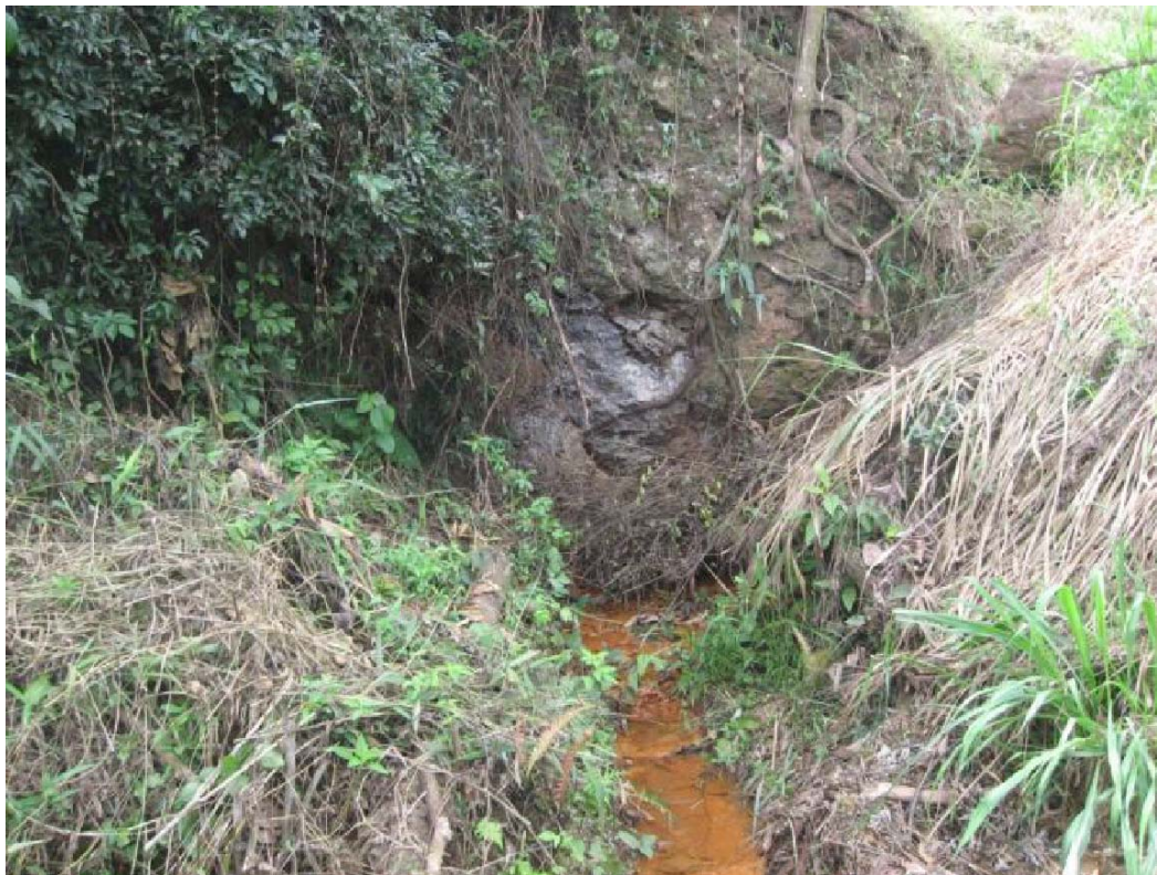
Figura 48: Detalhe de saída de água sob os blocos de canga, pé do dique inicial da B I
