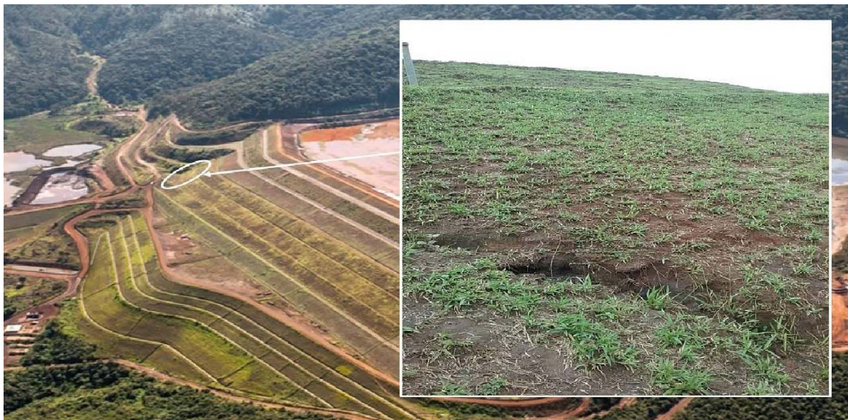
Figura 121: Ravinas na ombreira direita do talude
