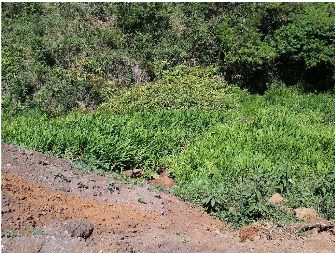
Figura 92: Vegetação alta no pé do talude
