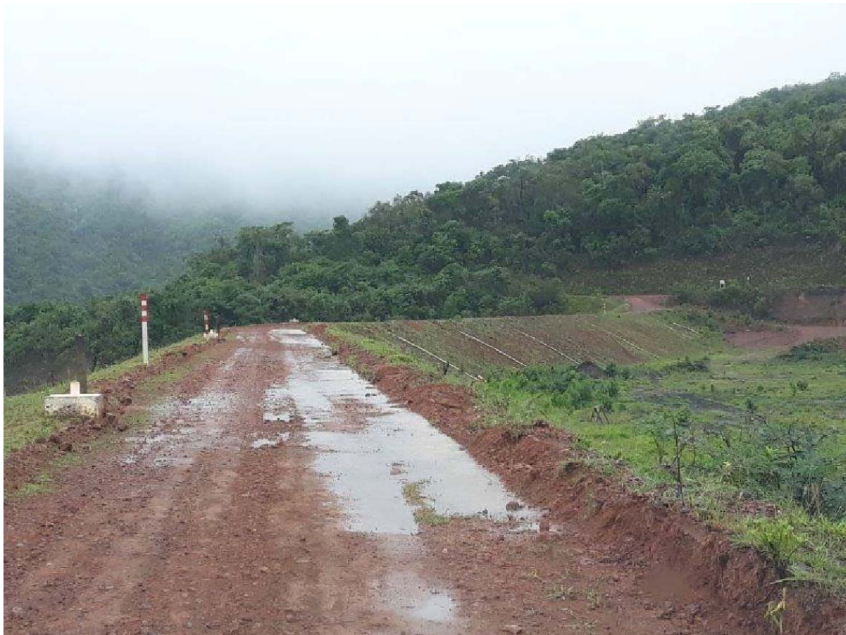
Figura 113: Drenagem superficial inadequada com formação de poças na crista do barramento
