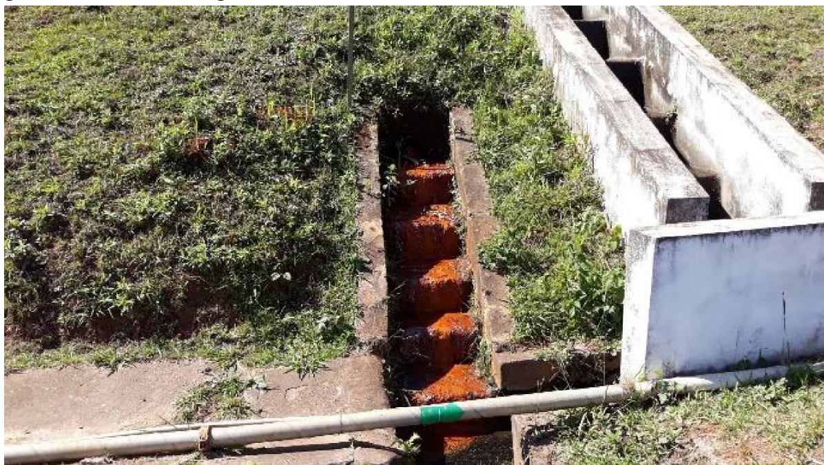
Figura 45: Saída de drenagem interna com colóide na B I
