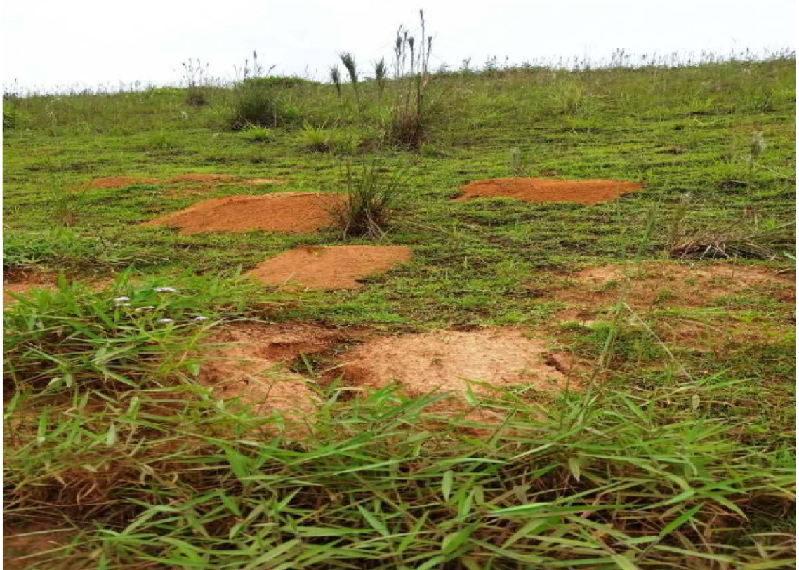
Figura 128: Formigueiros e cupinzeiros no barramento
