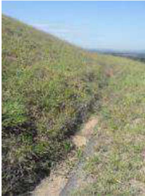
Figura 52: Trecho assoreado em canaleta de drenagem superficial acima da berma de recuo na B I
