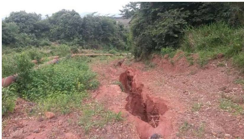
Figura 119: Erosão no acesso à barragem
