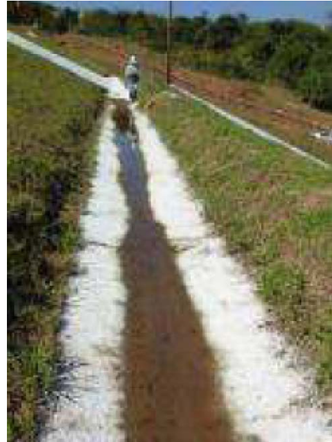
Figura 53: Trecho de canaleta de drenagem superficial da B I com acúmulo de água
