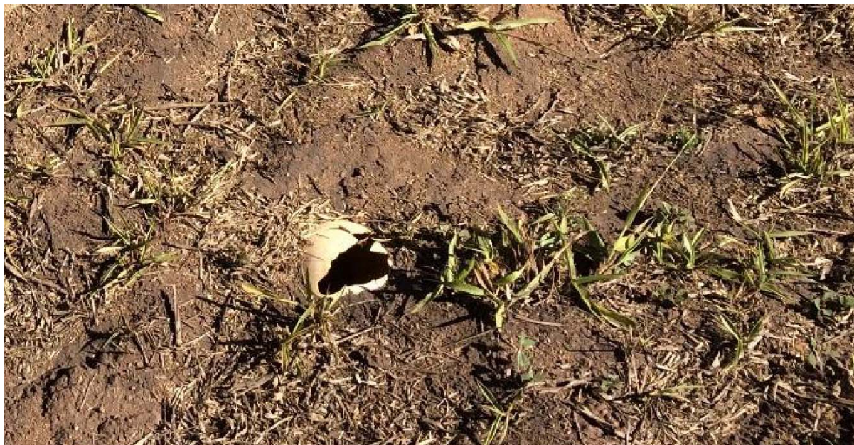
Figura 44: Tubo para saída de drenagem interna exposto e danificado na B I
