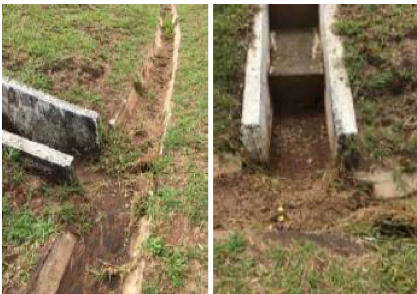
Figura 54: Canaletas de drenagem superficial na B I obstruídas por sedimentos
