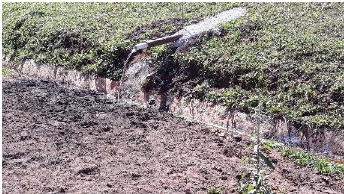
Figura 46: Um dos novos DHP instalados na B I sem a presença de sifão para evitar a entrada de ar
