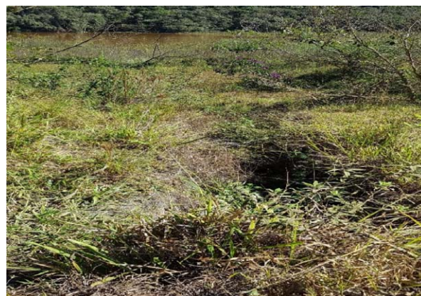
Figura 67: Bacia de dissipação para a Barragem VI totalmente coberta de vegetação
