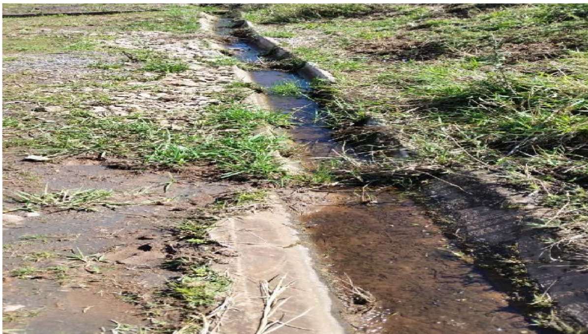
Figura 103: Canaleta assoreada e danificada pela ação de gado
