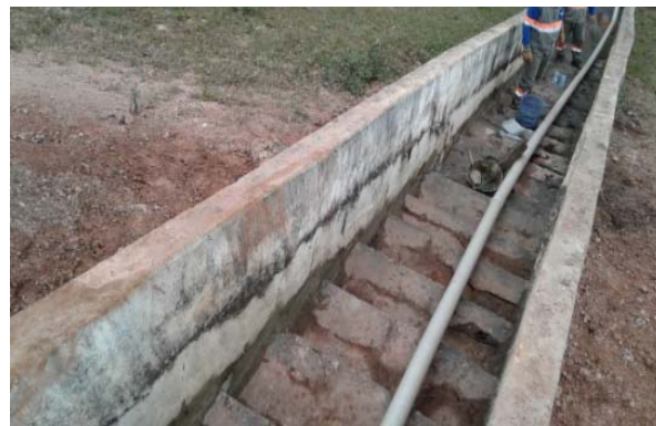
Figura 40: Tamponamento com massa de cimento e areia das trincas que surgiram na canaleta em degraus após o fraturamento hidráulico
